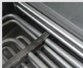
■ Doigt de gant protégeant le bulbe du thermostat pour une régulation parfaite
